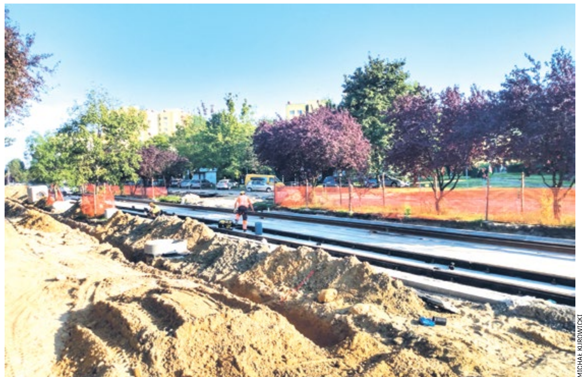
Na ulicy Rogowskiej trwa kładzenie szyn pod przyszłe torowisko. TAT pojedziemy w wakacje 2023
