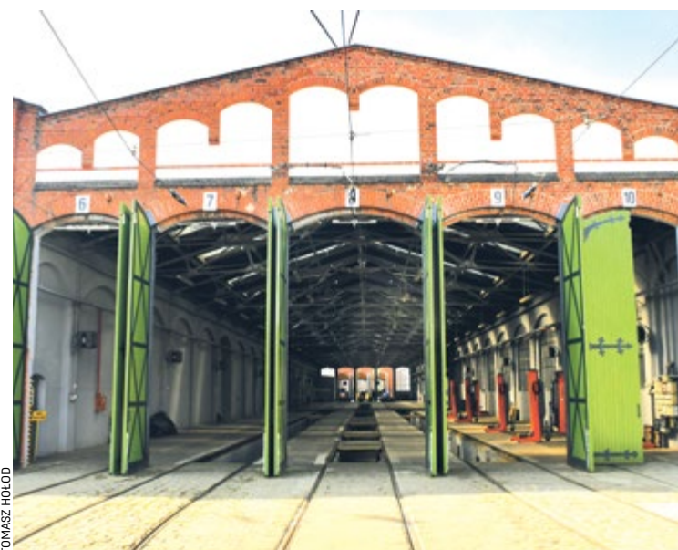
Prace remontowe obejmą posadzki, tory i kanały inspekcyjne
