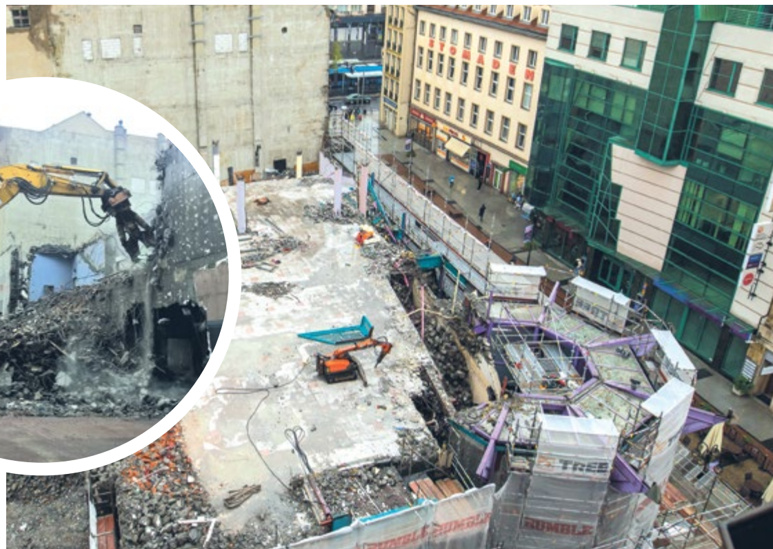
Rozbiórka Solpolu przy Świdnickiej dobiega końca, po dawnym domu handlowym zostały już tylko gruzy
