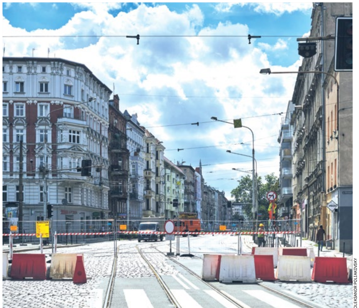
Teraz: wybrakowana miejscami kostka brukowa, łaty bitumiczne. Po remoncie Pomorska ma być równa
