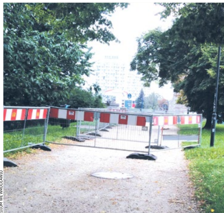
Budowa trasy pieszo-rowerowej już ruszyła, potrwa trzy miesiące
