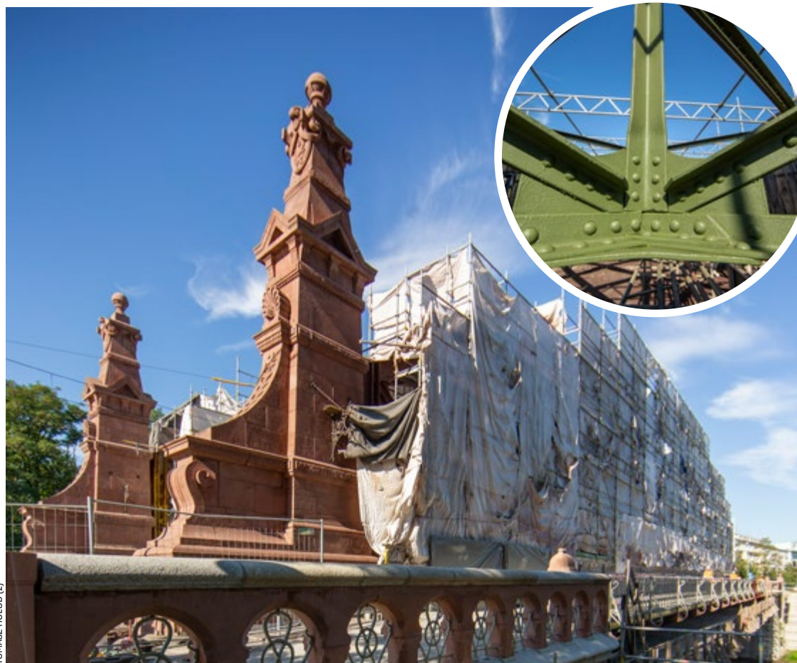
Wieżycy z czerwonego piaskowca zostały już oczyszczone, a konstrukcja nabiera koloru feldgrau (w kółku)
