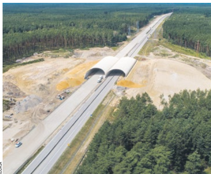
Prace remontowe na drodze krajowej nr 18 podzielono na cztery etapy
