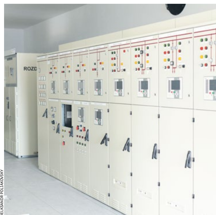
Stacja przetwarza prąd zmienny na stały do zasilania tramwajów
