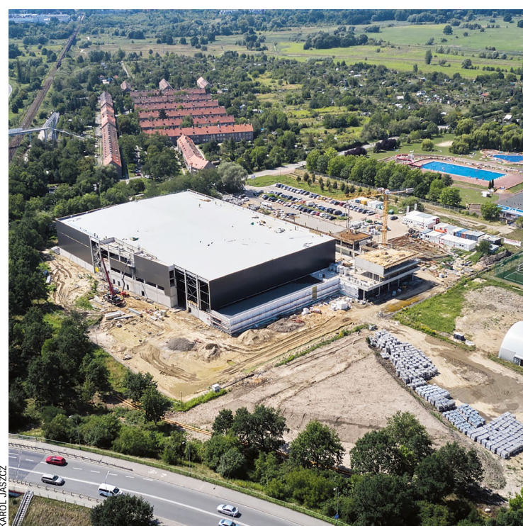
Widok z drona na nowo budowaną halę lekkoatletyczną
