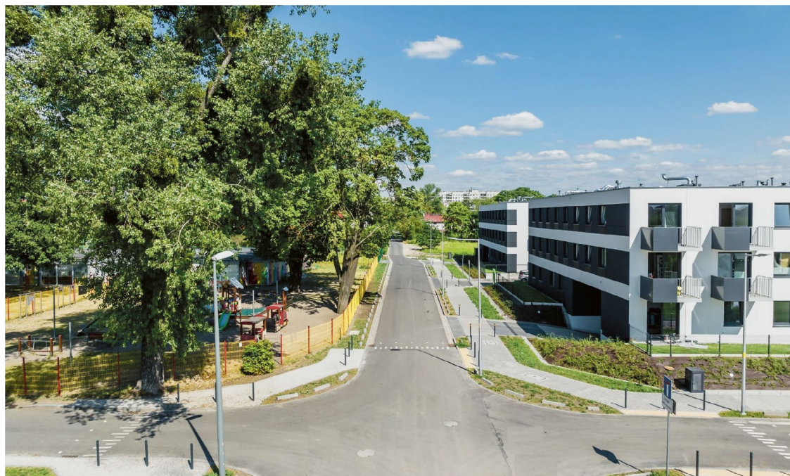
Tak prezentuje się ul. Zielna, która została wyremontowana, powstanie tu jeszcze dodatkowe oświetlenie
