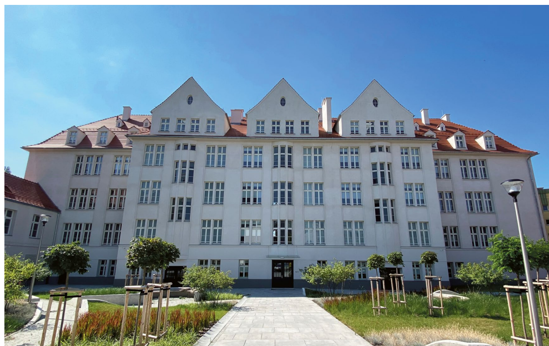
Remont budynków szpitalnych, które w 2015 roku kupiła Politechnika Wrocławska, trwał kilka lat
