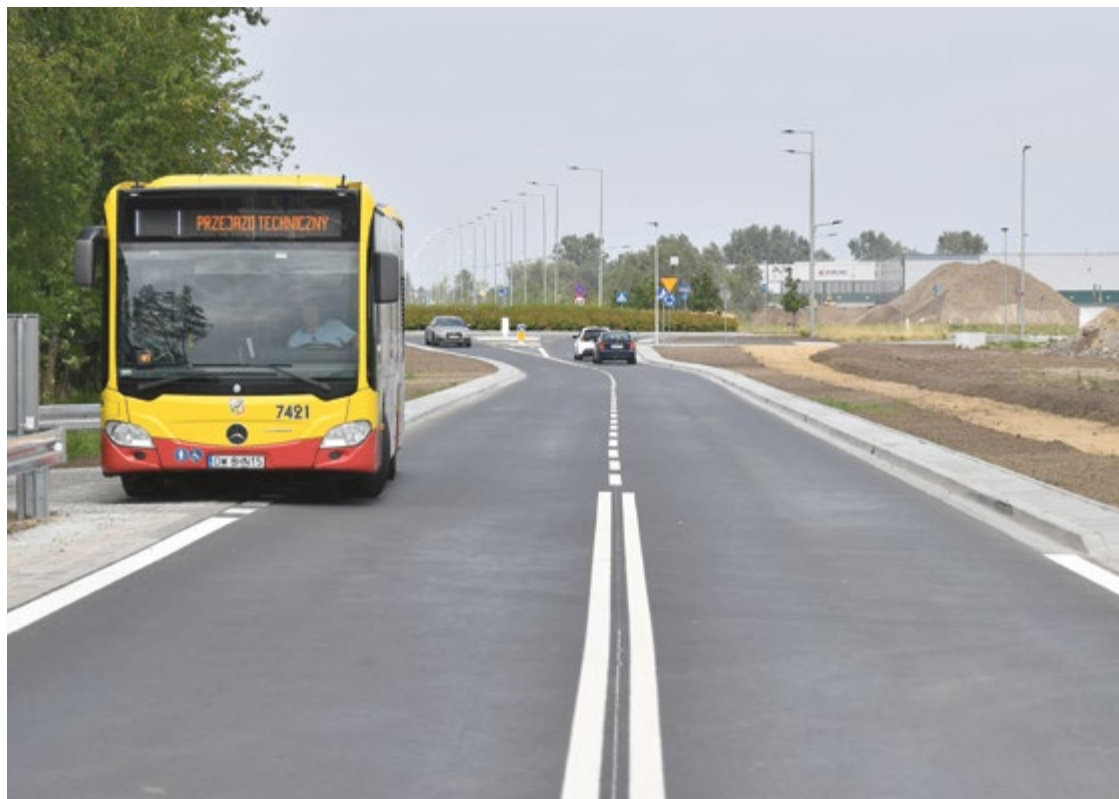
W nocy z soboty na niedzielę (30/31 lipca) został w pełni przywrócony ruch na ulicy Żwirki i Wigury
