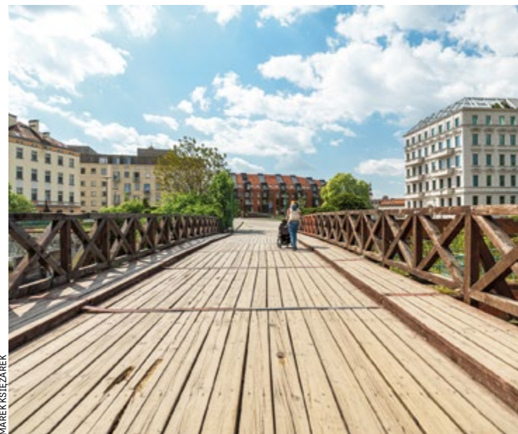
Konstrukcja zostanie zachowana w obecnym kształcie. Nawierzchnia, chodniki, balustrady będą wykonane z drewna dębowego
