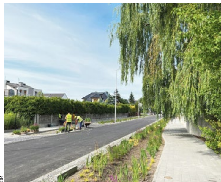
Nowa droga na Ołtaszynie ma 300 m, powstał też chodnik i oświetlenie
