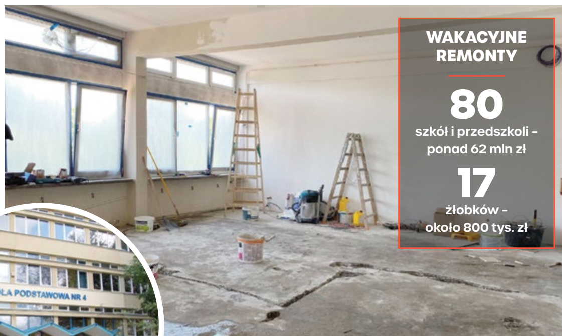
Remont sali dydaktycznej trwa właśnie w SP nr 4, zerwano boazerię z lat 70., by sala stała się kolorowa i nowoczesna
