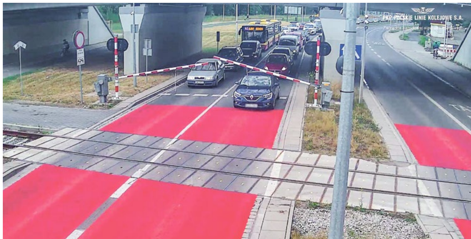
Na przejeździe kolejowym przy ul. Zwycięskiej samochody wjeżdżające w czerwoną strefę rogatek uszkadzają je, na długo blokując ruch
