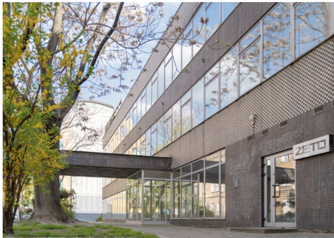
Anna i Jerzy Tarnawscy zaprojektowali nową siedzibę ZETO. Budynek stanął przy ul. Ofiar Oświęcimskich 7-13
