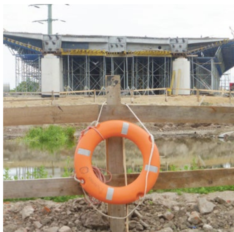
Powstają konstrukcje stalowe pod budowę mostu nad rzeką Oławą
