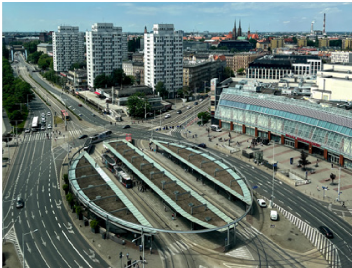
Centralne skrzyżowanie „Grunwald” po przebudowie w l. 2006-2007 nazwano rondem Reagana
