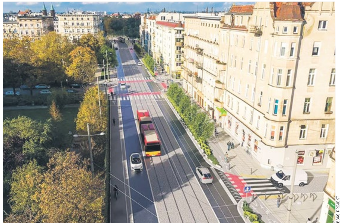
Na jednej z głównych arterii Nadodrza zniknie większość kostki brukowej, zastąpi ją asfalt
