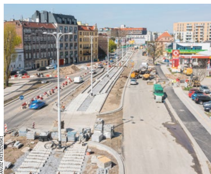
Asfalt wylano najpierw na trasie rowerowej, potem na jezdni
