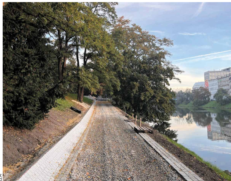
Prace na Promenadzie Staromiejskiej, 6 października 2026
