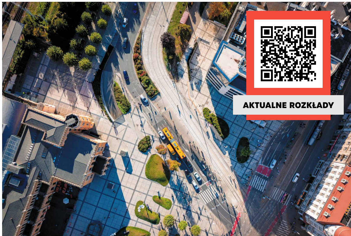
Torowisko na ul. Peronowej już działa, ale część tramwajów jeździ objazdem, a autobusy wrócą tu 3.10
