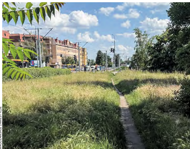
Wykonawca ma 8 miesięcy na wykonanie drogi rowerowej
