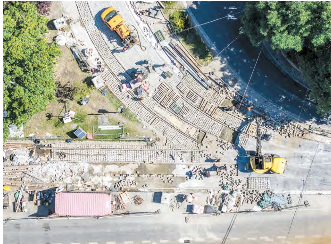
Widok na remont torowiska w pobliżu Dworca Głównego PKP – na ulicach Stawowej i Peronowej
