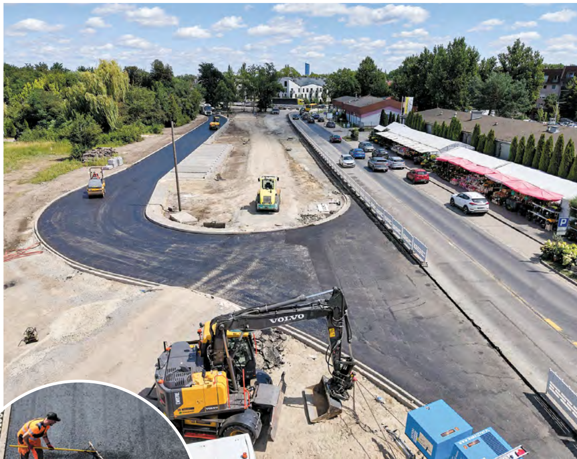
Prace w lipcu przy budowie łącznika pomiędzy Awicenny a Mokronoską
