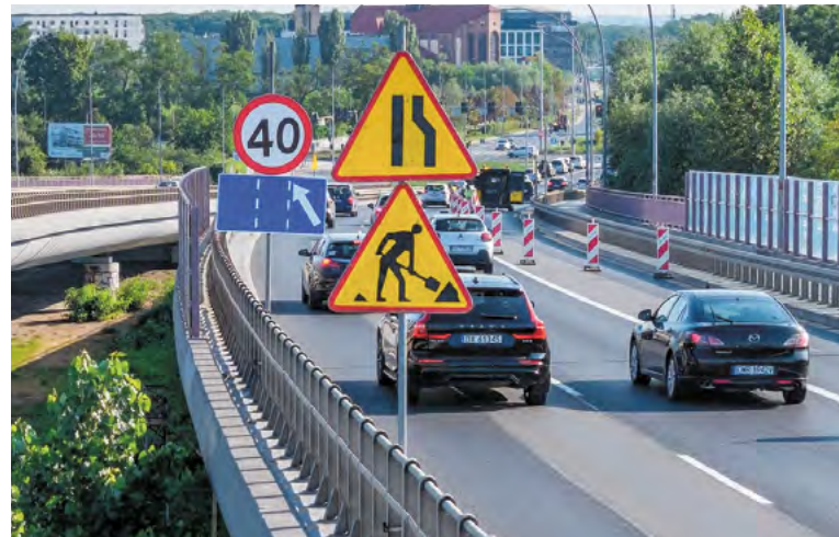
Znaki i barierki przypominają o rozpoczęciu remontu na Gądowiance
