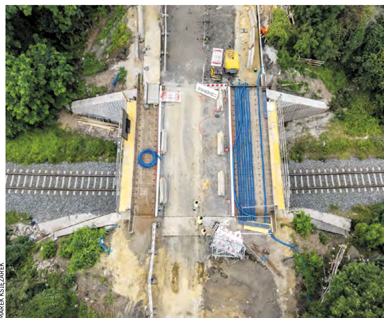
Wiadukt na ul. Gazowej od strony Tarnogaju jest już niemal skończony
