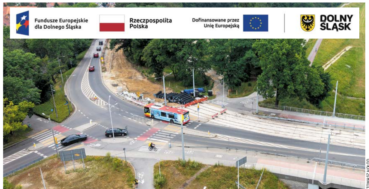
Widok na postępujące etapy prac przy budowie pętli „Sępolno”, która będzie początkiem nowej trasy
