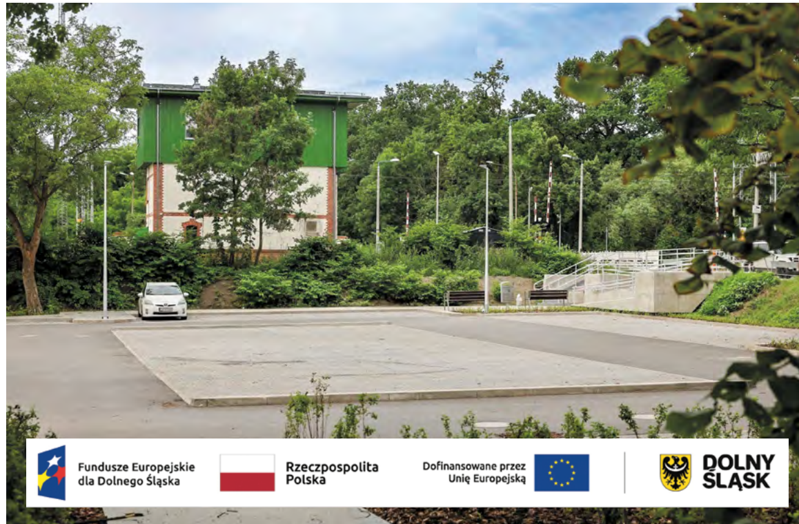
Zakończyły się prace przy budowie parkingu P+R w Leśnicy – będzie można z niego korzystać już w lipcu
