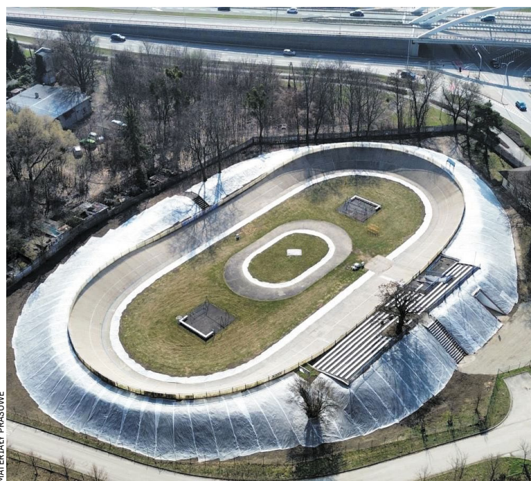
Zakończył się pierwszy etap prac na torze przy ul. Żmigrodzkiej
