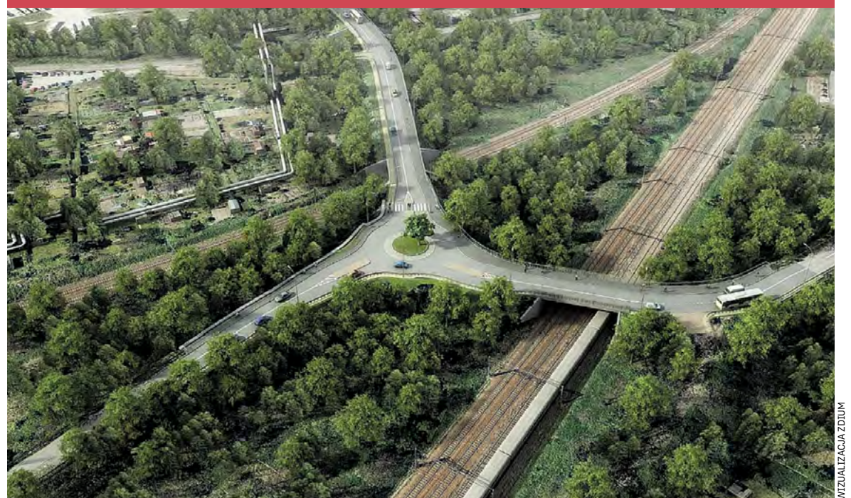
Ulice Gazowa i Karwińska po przebudowie – po remoncie rondo zastąpi trudne skrzyżowanie (zdj. na okładce)
