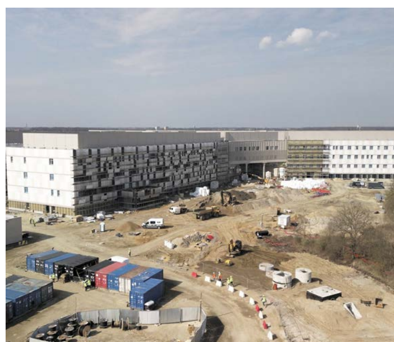
Prace elewacyjne na kolejnych skrzydłach DCOPiH są już na ukończeniu
