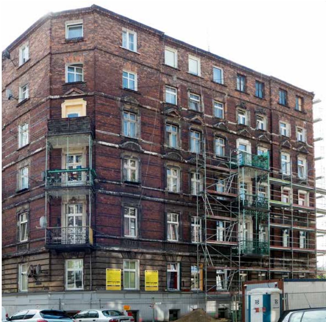
Remont kamienicy miejskiej przy ul. Mierniczej 15
