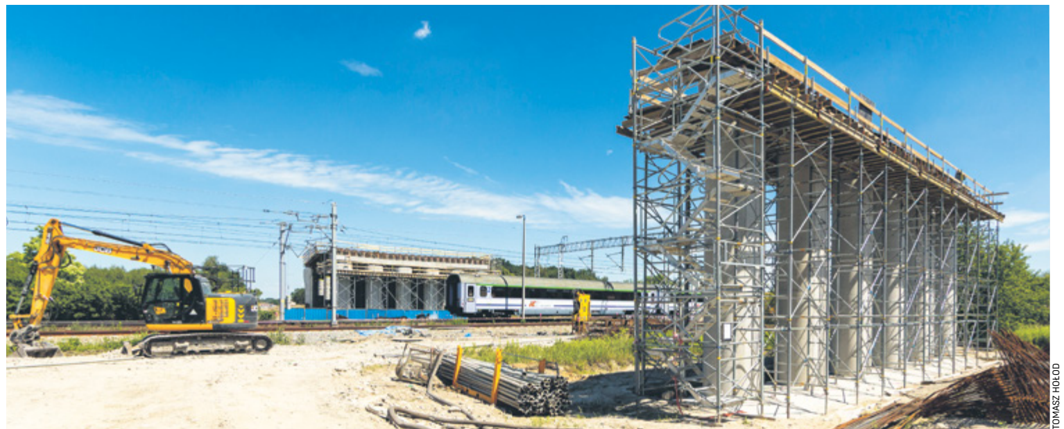
Wiadukt powstaje nad linią kolejową nr 275 z Wrocławia do Gubinka przez Legnicę. Nocą na kilka godzin wstrzymywany jest ruch pociągów
