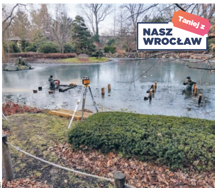
Na zlecenie ZZM powstaje nowa konstrukcja nośna pomostu
