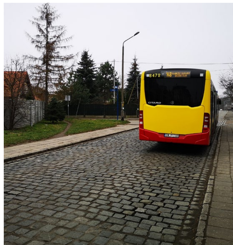
Kostka prawie całkowicie zostanie zastąpiona przez asfalt
