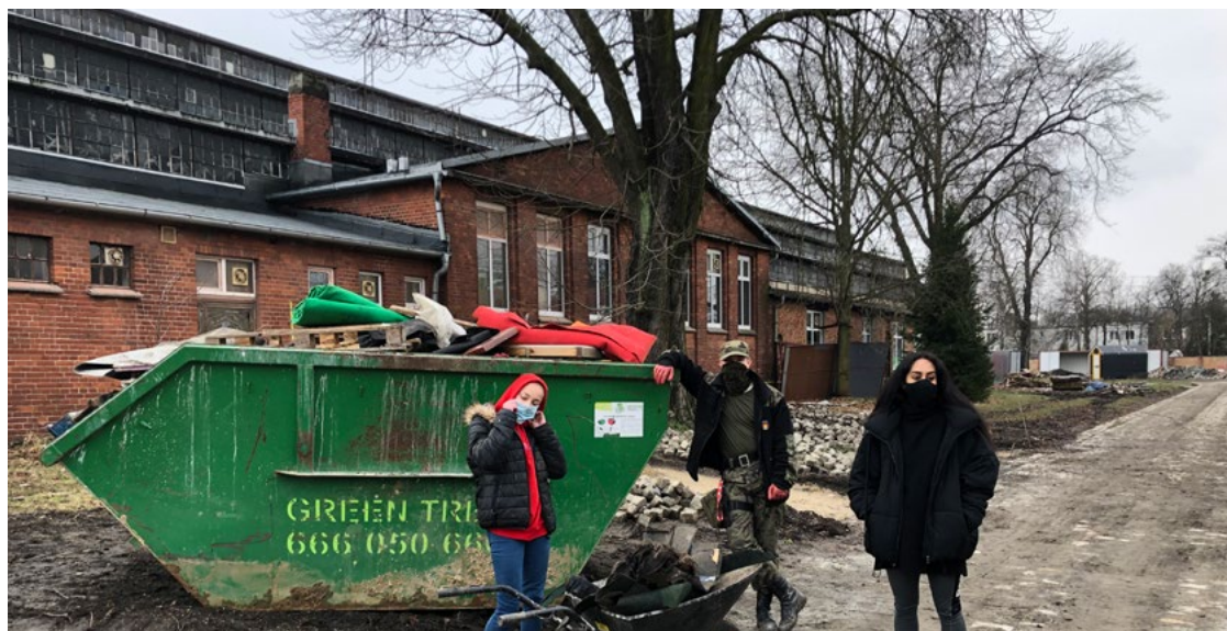
W Czasoprzestrzeni (ul. Tramwajowa 1-3) trwają przygotowania do stworzenia ogrodu społecznego
