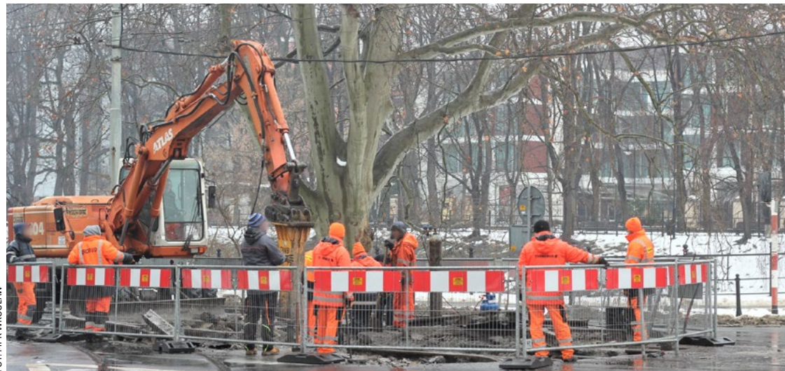
Remont torowiska na skrzyżowaniu Podwala, Krupniczej i Sądowej – wymiana zwrotnicy
