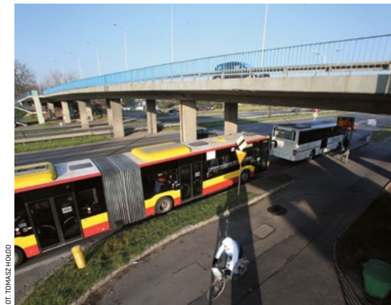
Prace na wiadukcie obejmą: wymianę nawierzchni jezdni i chodników, naprawę elementów konstrukcji, wymianę oświetlenia
