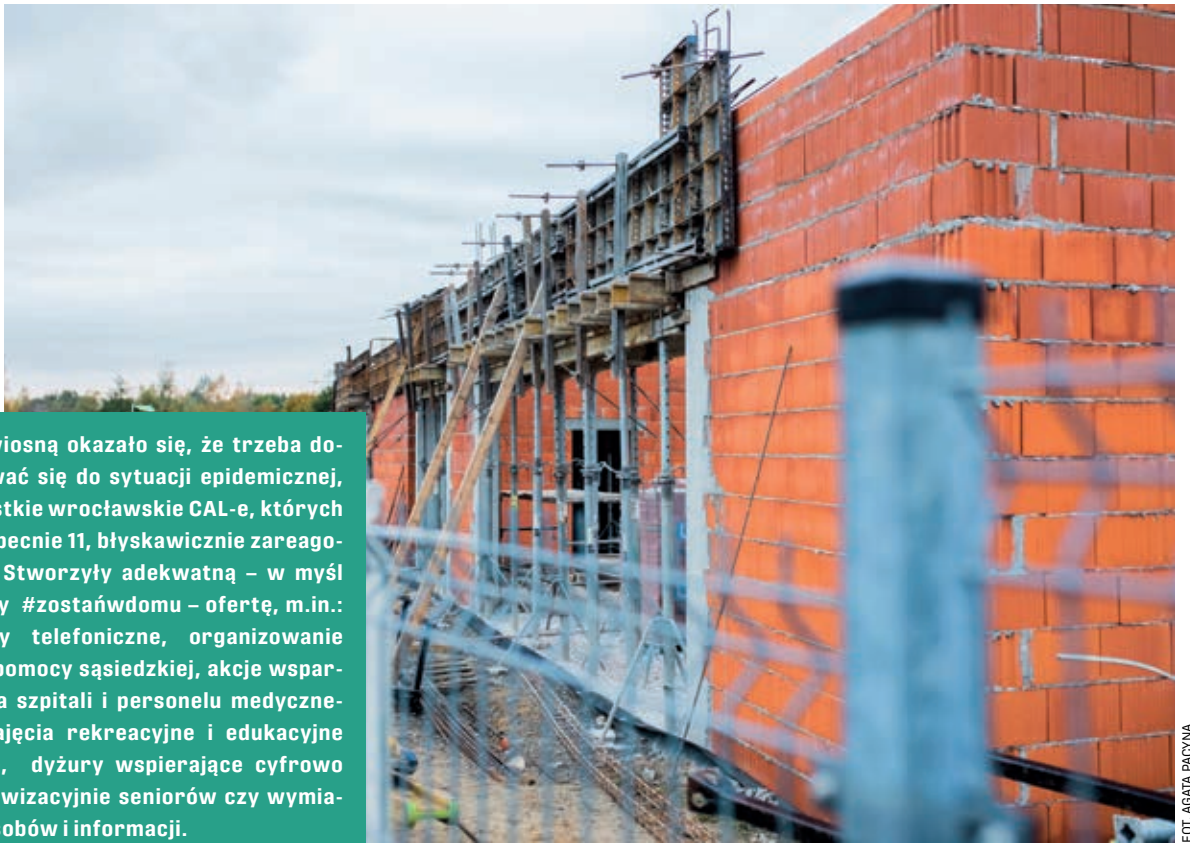
Budynek CAL jest wznoszony na działce o pow. ponad 1,8 tys. m 2
