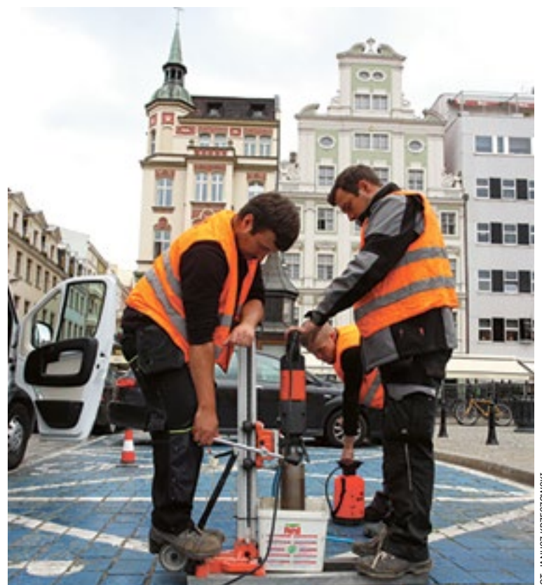
Montowanie systemu zajętości miejsc parkingowych
