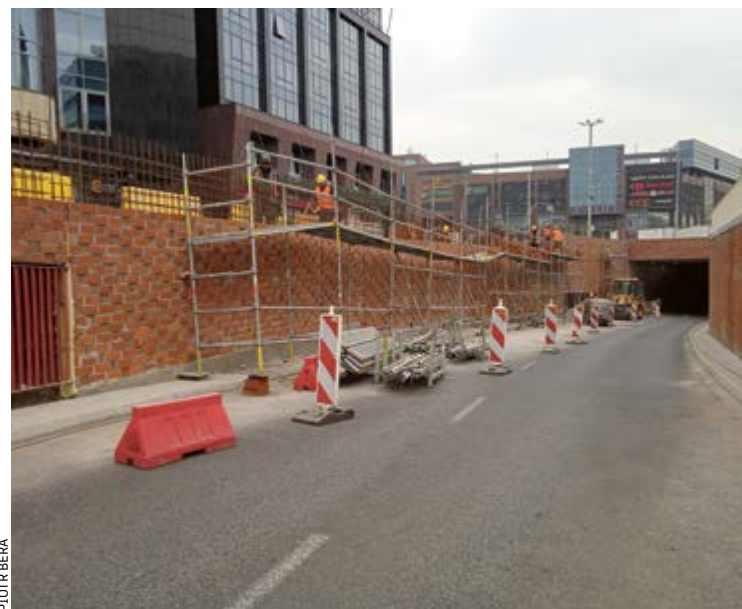
Do remontu ścian tunelu użyto łącznie 30 tysięcy cegieł
