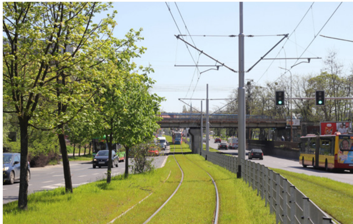
O remont torów wnioskowali mieszkańcy osiedla Grabiszyn-Grabiszynek. Skorzysta cały Wrocław
