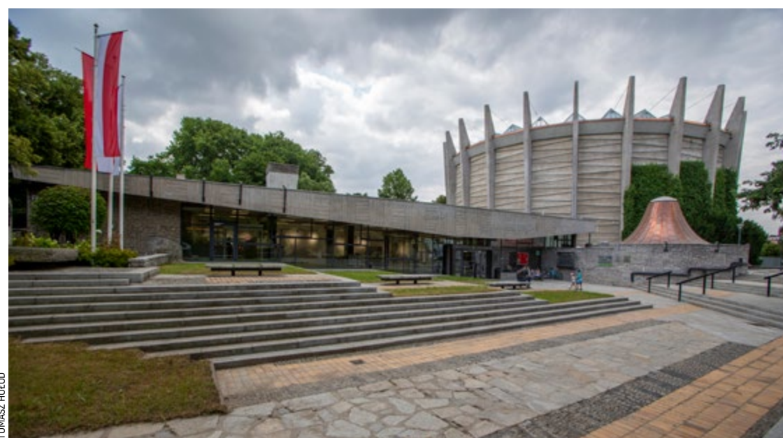
Po modernizacji budynek Panoramy Raclawickiej jest dostępny dla osób z niepełnosprawnościami
