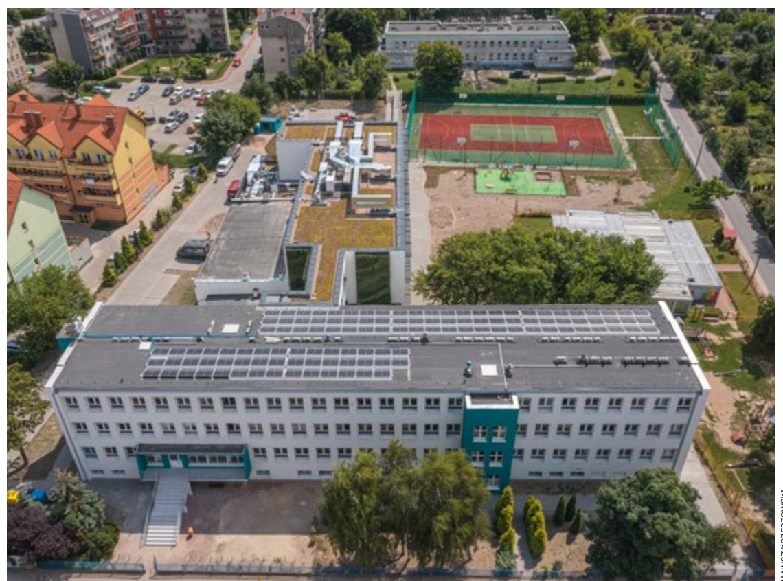
Trwają właśnie odbiory techniczne w SP 99 przy ul. Głębczyckiej 3
