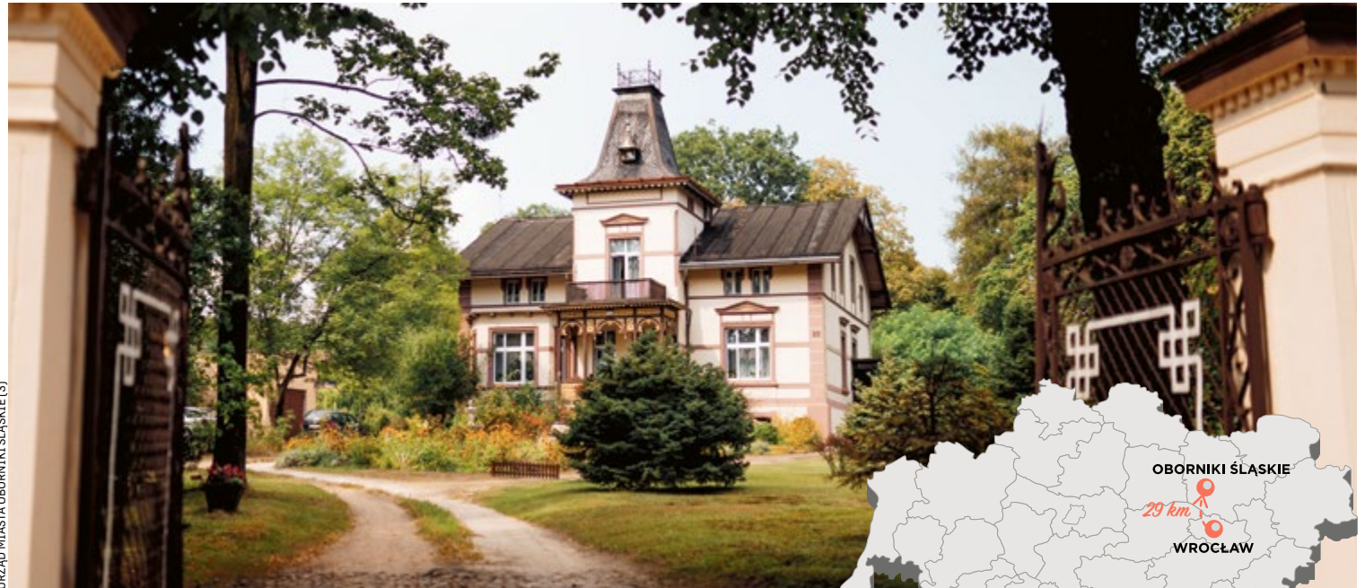
Zabytkowa willa przy ul. Dworcowej 10 w Obornikach Śląskich pochodzi z XIX w.
