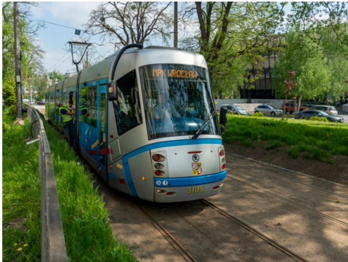
Ponad 11 mln 633 tys. zł kosztowało wybudowanie odcinka TAT od ul. Śrubowej do pętli WPP
