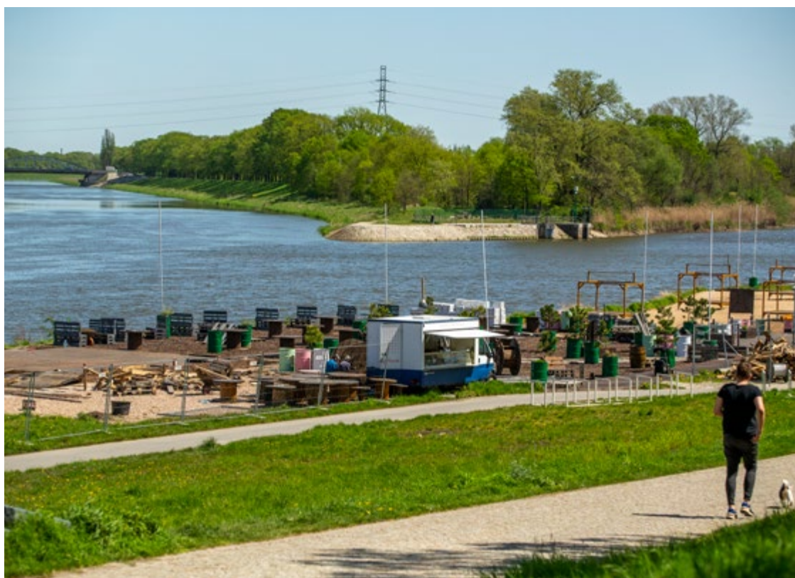
Prace przy budowie miejskiej plaży Prosto z Mostu przy mostach Warszawskich idą pełną parą
