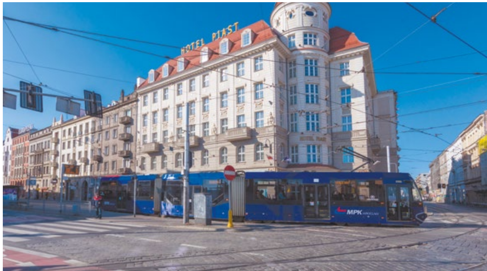
Jedną z zaplanowanych na ten rok inwestycji torowych jest kompleksowy remont węzła tramwajowego pod Dworcem Wrocław Główny
