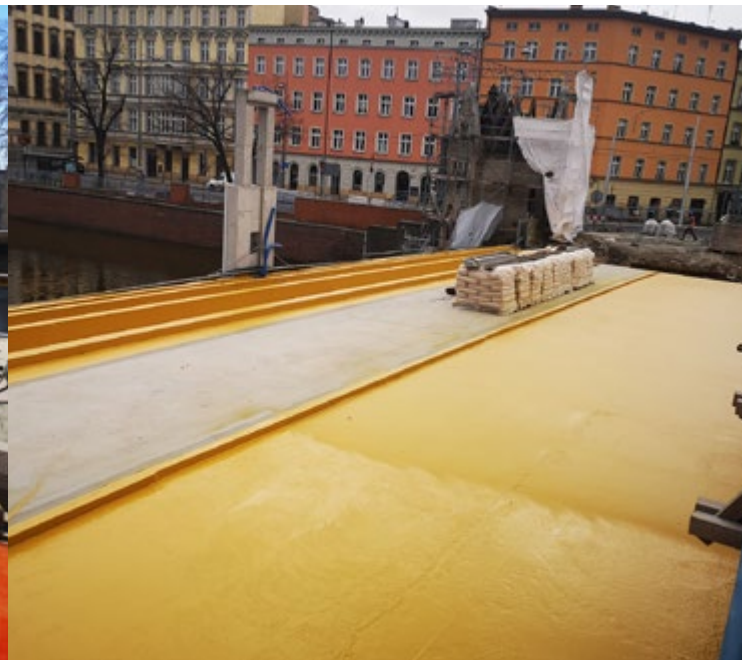
Most Pomorski chwilowo dwukolorowy przed wylaniem asfaltu: Północny pomalowany czerwoną farbą izolacyjną, Południowy – żółtą
