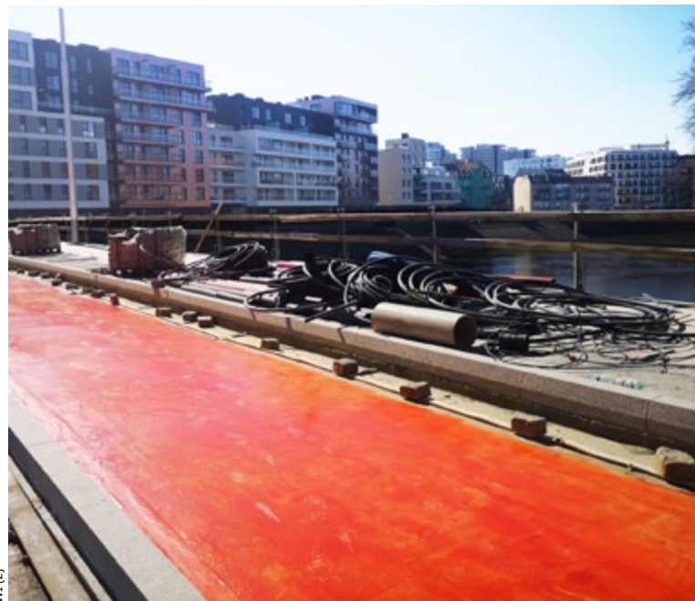
Most Pomorski chwilowo dwukolorowy przed wylaniem asfaltu: Północny pomalowany czerwoną farbą izolacyjną, Południowy – żółtą
