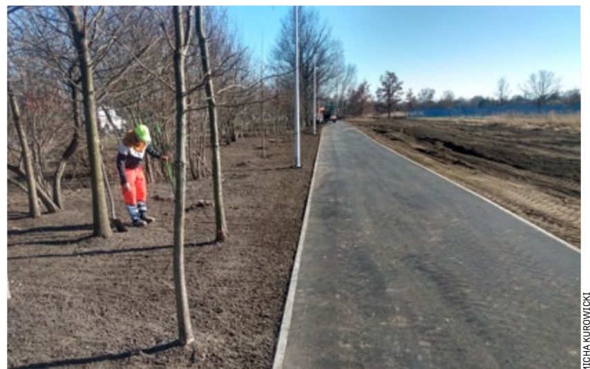
Trwają ostatnie prace porządkowe i sadzenie zieleni wzdłuż ścieżki
