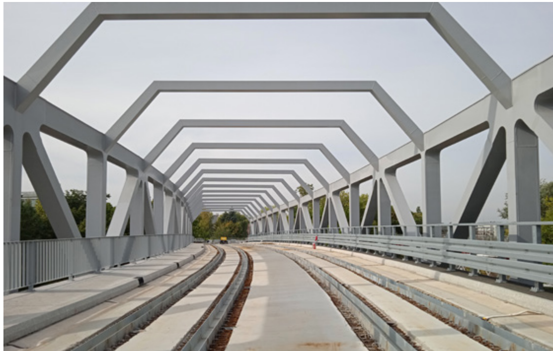
Konstrukcja wiaduktu na ul. Strzegomskiej jest już gotowa, autobusy pojedą tędy za rok
