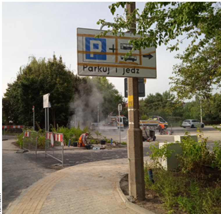
Robotnicy zajmują się ostatnimi pracami wykończeniowymi
