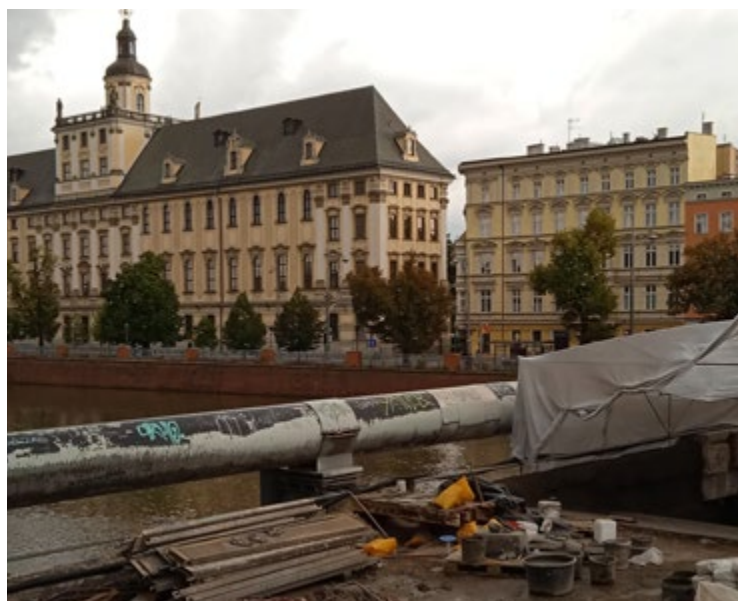
Do końca października obie rury zostaną ukryte w mikrotunelu
