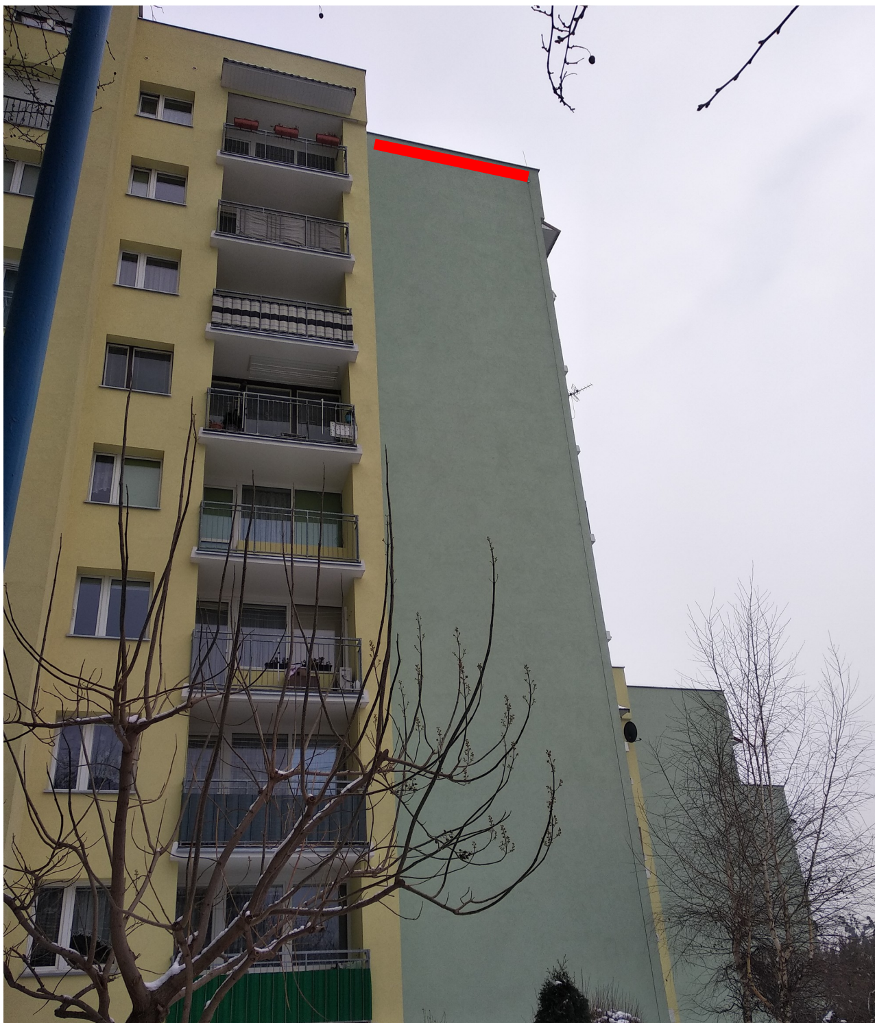
Zdjęcie nr 3: Ściana zachodnia: proponowane jest powieszenie 3 dwubudkowych paneli dla jerzyków (wróbli). Budki powinny być rozwieszone bezpośrednio pod okapem dachu. Odległość między panelami powinna być około 0,5 metra.
