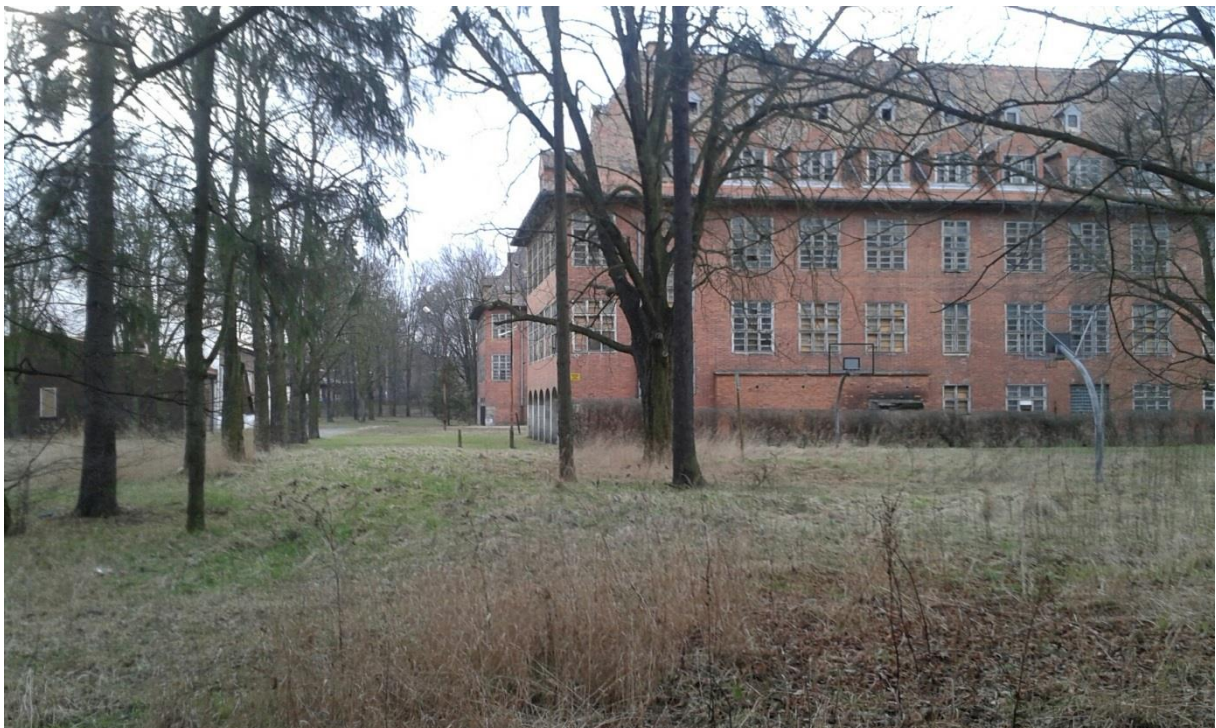
Fotografia 2: boisko do koszykówki (po prawej stronie) – stan obecny
