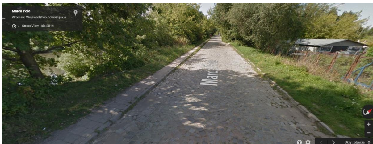
Fot. 3 Kocie łby, szczątkowy chodnik po południo-zachodniej stronie
