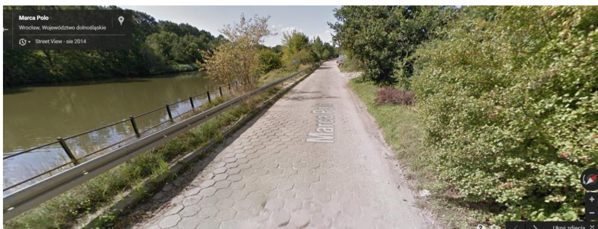
Fot. 2 Brak chodnika, niska jakość jezdni (kostka betonowa)
