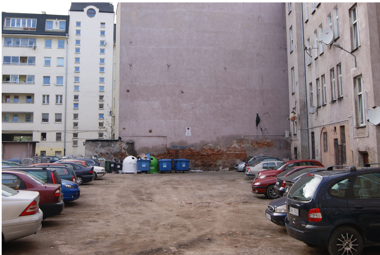
Widok z przejścia dla pieszych od ulicy Drobnera
