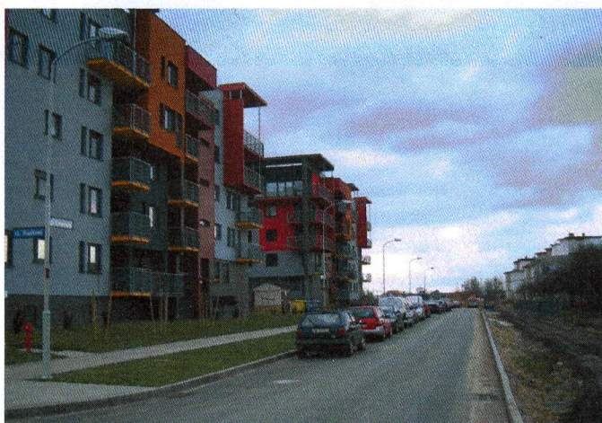
Fot. 1-2 Nowe kompleksy budynków wielorodzinnych na terenie osiedla Lipa Piotrowska
