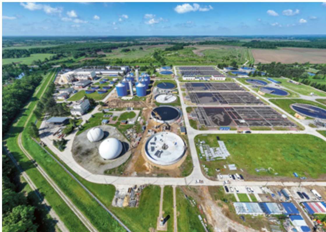
WROŚ – Wrocławská Oczyszczalnia Ścieków na Janówku przechodzi modernizację wartą 311 mln zł
