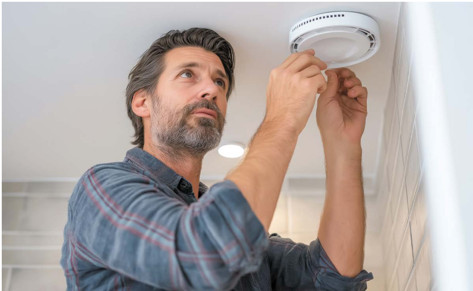
Czujniki wykrywające czad i dym to niezbędny element wyposażenia domu, w którym zainstalowany jest piec grzewczy
