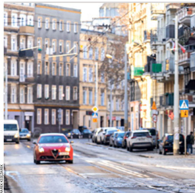
Ulice Słowiańska i św. Wincentego wymagają gruntownego remontu
