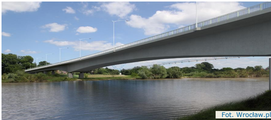
Budowa mostu Alei Wielkiej Wyspy
