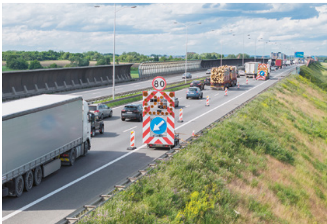
Roboty drogowe na AOW prowadzone są między węzłami Wrocław Zachód i Psie Pole. Zdjęcie z 5.06
