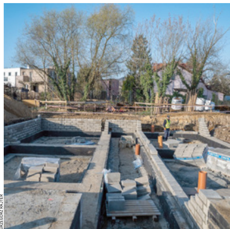
Na budowie przy ul. Morawskiej widać już zarys budynku centrum
