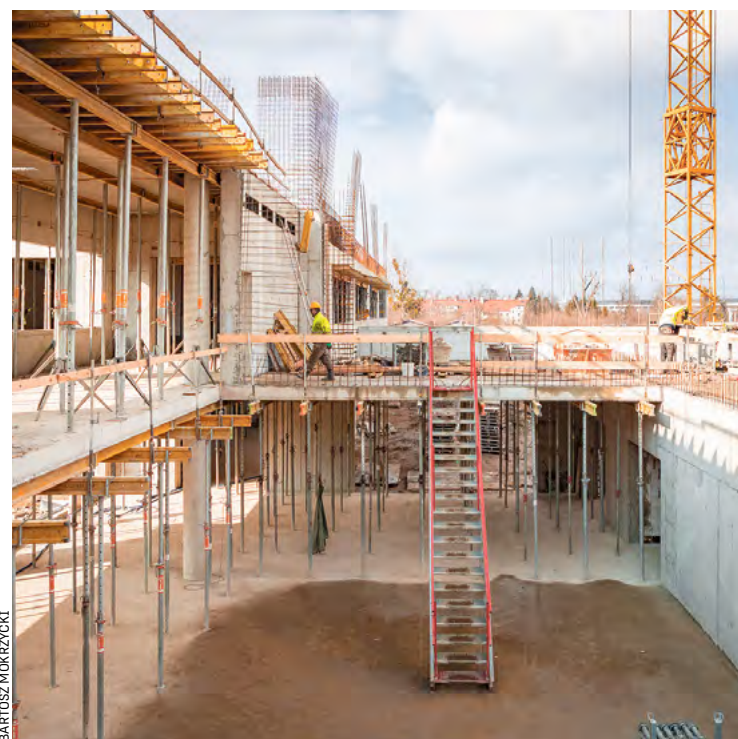
Gotowa już jest konstrukcja Zespołu Szkolno-Przedszkolnego
