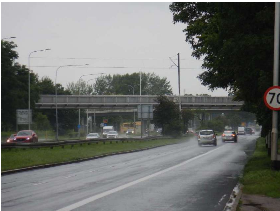
Rysunek 28 Widok na wiadukt kolejowy w km 20,437 linii kolejowej nr 292
