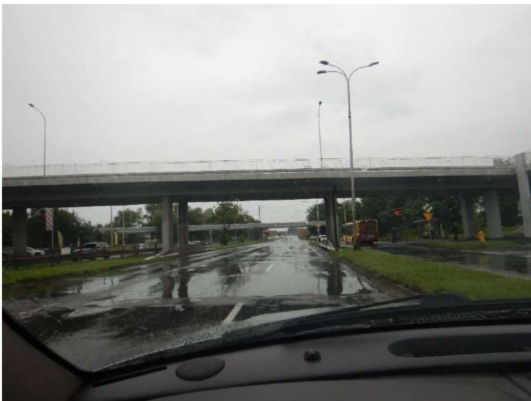
Rysunek 29 Widok na wiadukt drogowy w ciągu ulicy Kowalskiej
