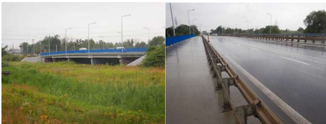
Rysunek 27 Widok ogólny (z lewej) i widok części ruchowej (z prawej) mostu w ciągu ul. Bolesława Krzywoustego nad Doliną Widawy
